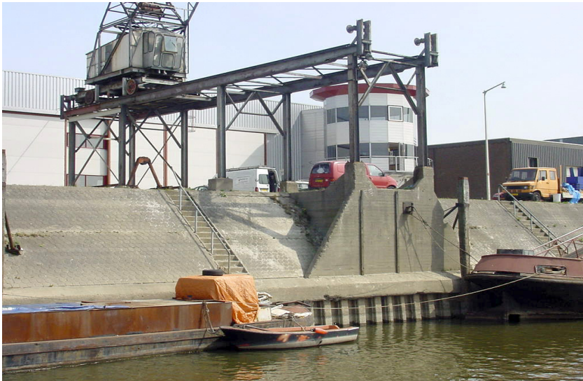
afb. 2: kraanbaan gezien vanuit de haven, naar het zuidoosten
